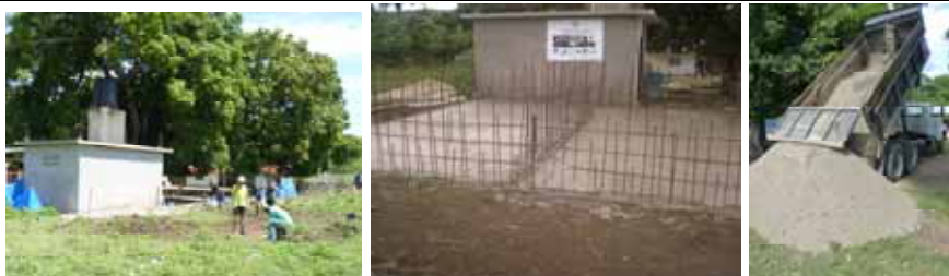
Station en cours de construction à Grand Gôave
