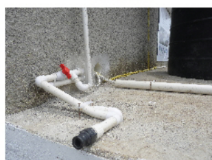
Equipement du puits et mise en place de la pompe
