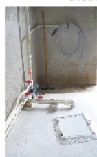
Finitions et mise en place du matériel de maintenance
