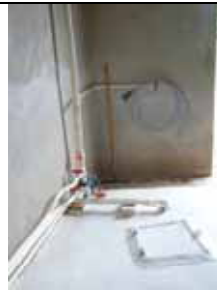
Local dédié uniquement à l'eau
