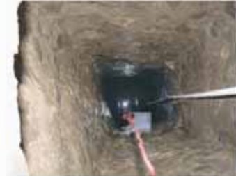
Equiperment du puits et mise en place de la pompe
