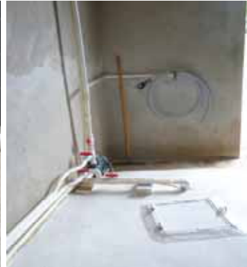
Tube de distribution et râtelier de maintenance en permanence stocké dans le local technique.
