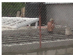
Mise en place de la clôture
