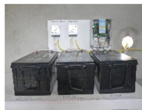
Mise en place de la partie énergétique
