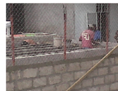
Vue générale du mur d'enceinte
