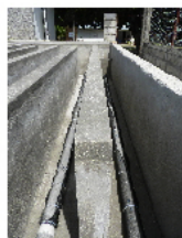
Mise en place des drains de filtration
