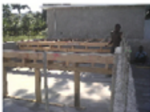
Préparation des deux barres horizontales de renfort anti-sismique du réservoir
