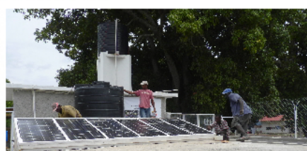
Mise en place et sécurisation des panneaux solaires
