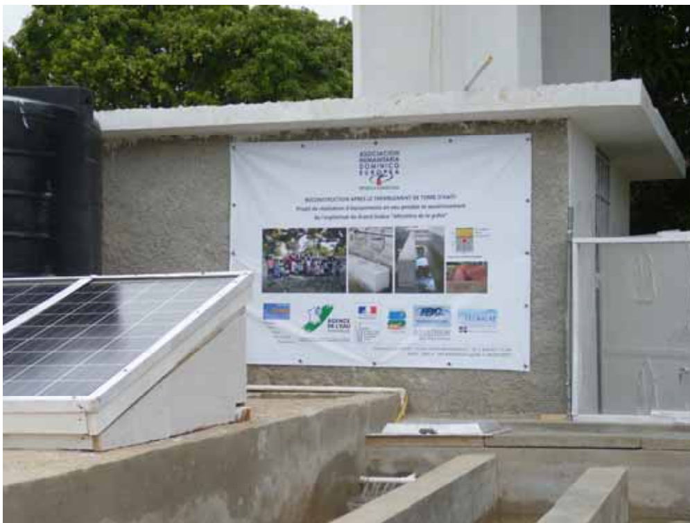
Vue du support des panneaux solaires et de la porte métallique du local
