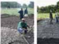
Du mardi 03 au jeudi 05 mai 2011 Mise en place des graviers et du ferrillage
