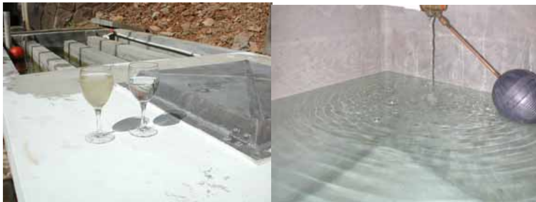
Station et citerne attenante.
