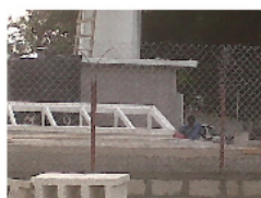
Réalisation des supports des panneaux solaires
