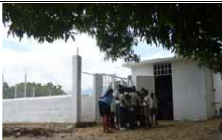
Abords du puits sécurisé et drainé
