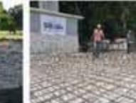
Du mardi 03 au jeudi 05 mai 2011 Mise en place des graviers et du ferrillage
