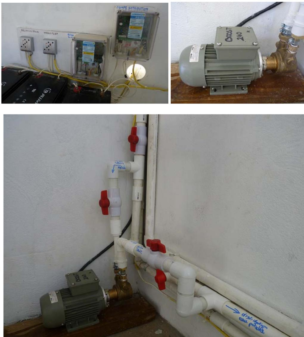
*Vues de la pompe installée - tableau électrique et by-pass.*
