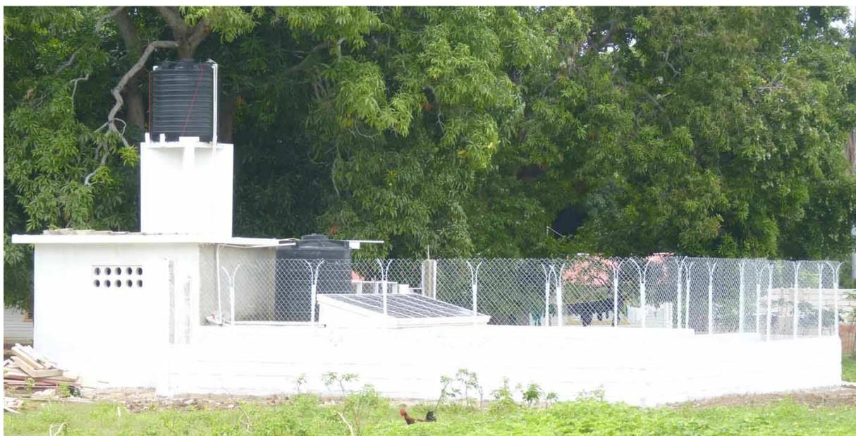
C'est ainsi que nous avons construit une station de production d'eau potable produisant **15 m<sup>3</sup>/jour**, sur base du procédé de Rétrofiltration Lente (RFL). La station est entièrement solaire et autonome. Un réseau d'eau potable (lavabos, évier, douches, fosse septique, drainage...) a été construit et alimente toujours l'orphelinat à ce jour.
