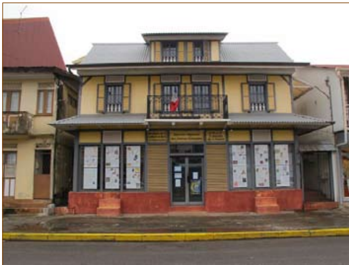
Locaux de la DRAC Guyane à Cayenne © DRAC Guyane
