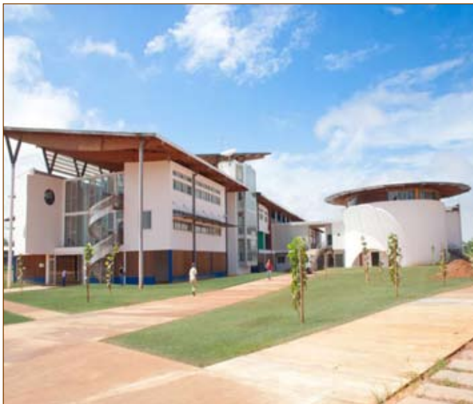
Bâtiments de l'IUFM © IUFM
