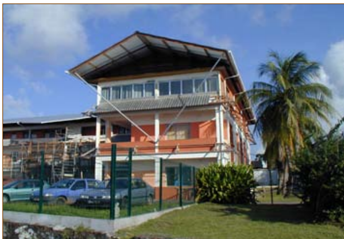
Bâtiment de la DRIRE à Cayenne © DRIRE
